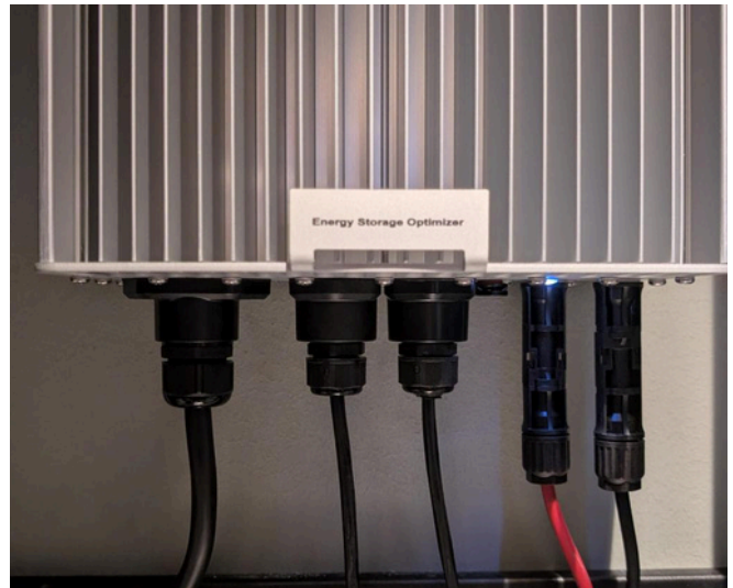
Bild 2. Inkoppling av ESO15.
