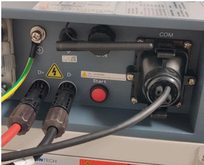
Bild 1. Inkoppling av BMS med en stapel.
