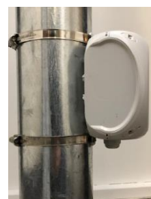
Montage på stolpe
