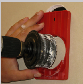
Använd 74mm multifräs och borra ut cirkeln.
