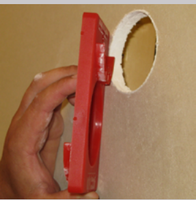
Borra ett håll där dubbeldosan ska sitta. Sätt in borrmallen, så ett nytt hål kan fräsas ut.
