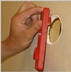
Mallen för utfräsing placeras i det utborrade hålet.
