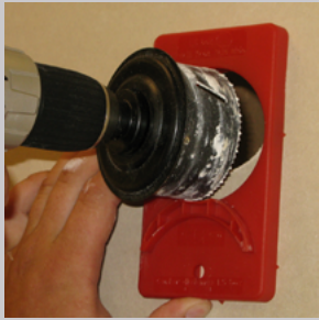
Använd 74mm multifräs och borra ut halvmånen.
