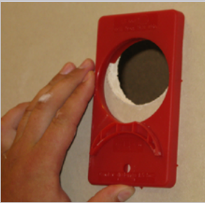
Sätt in borrmallen så att du får en halvmåne i hålet.
